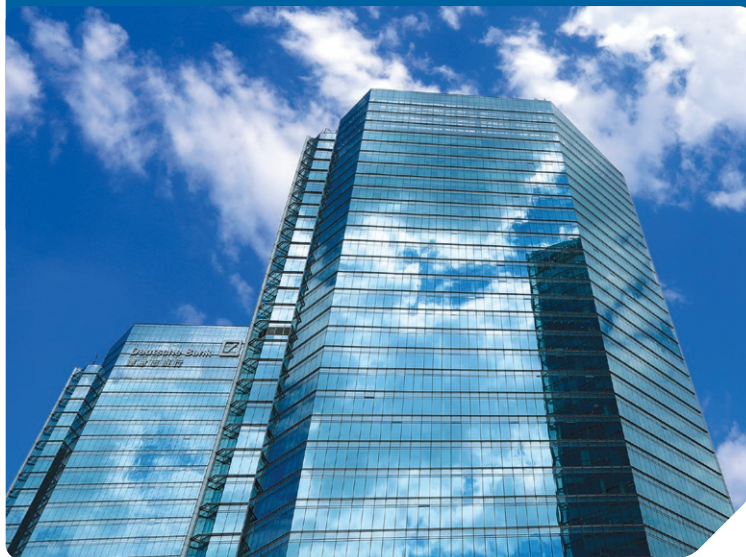
北京華貿中心1座及2座寫字樓
